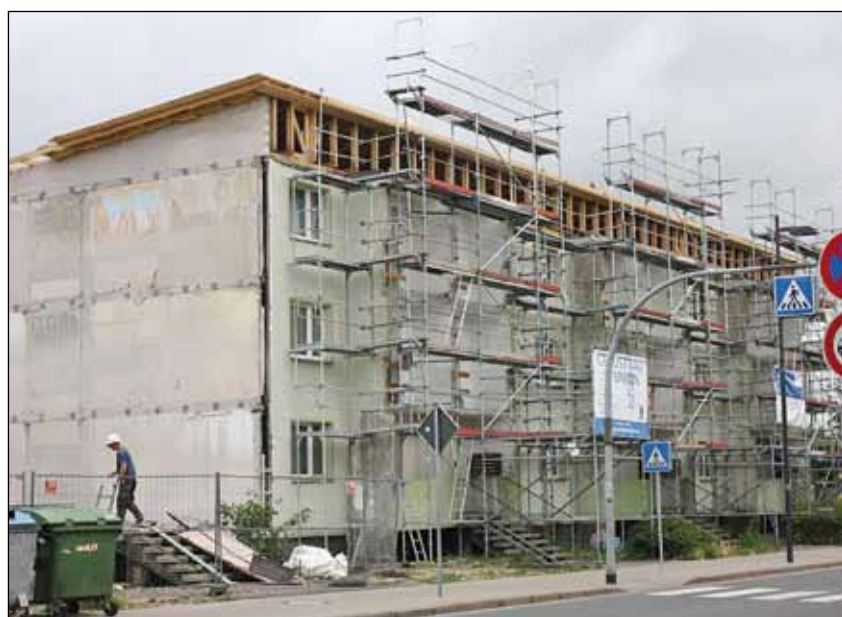
Der Teilrückbau in der Straße der Neuen Zeit ist in vollem Gange. Auf dem Foto ist gut zu erkennen, dass das Gebäude nun nur noch über 3 Etagen verfügt. Der Hauseingang Nr. 1 ist völlig zurückgebaut worden. Das neue Dach ist bereits zu sehen.
