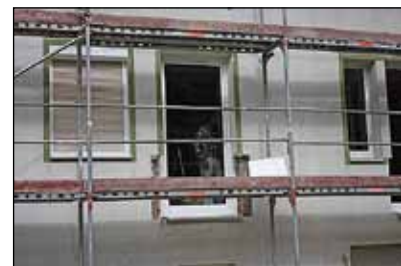
Vor dem Anbau der Balkone werden in der Albert-Schweitzer-Straße 45 – 49 Türen eingesetzt.
